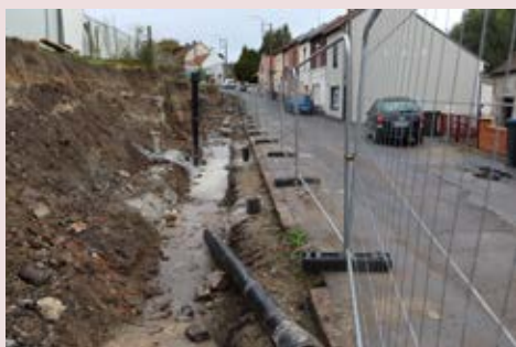
Rue André Gourdin, les travaux d'aménagement continuent
