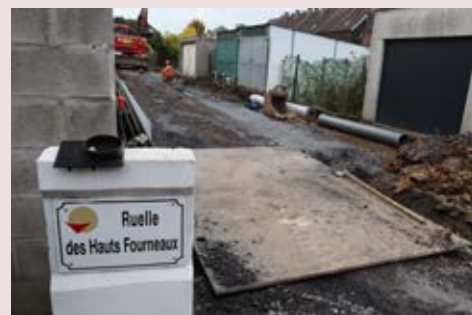
Des travaux de réfection de voirie, de pose de bordures et caniveaux sont réalisés ruelle des hauts fourneaux dans le quartier du Poirier
